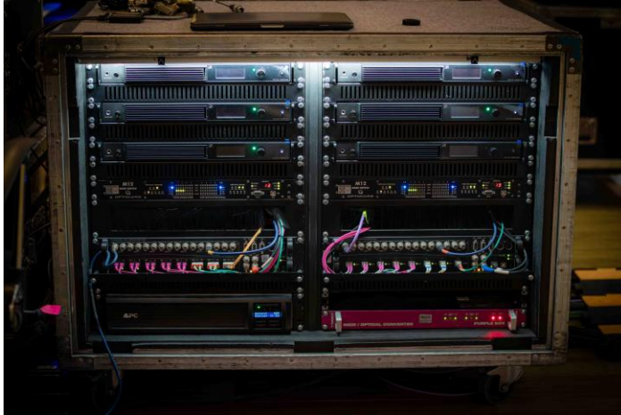
Sechs Spectera Base Stations (oben im Rack) waren im Sound Room im Einsatz: vier aktive Base Stations, eine für das Scanning und ein Ersatzgerät
